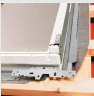
Теплоізоляційний контур надійно утеплює периметр вікна
