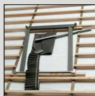
Всі елементи комплекту BDX 2000 повністю відповідають розмірам вікна і не потребують додаткової підгонки
